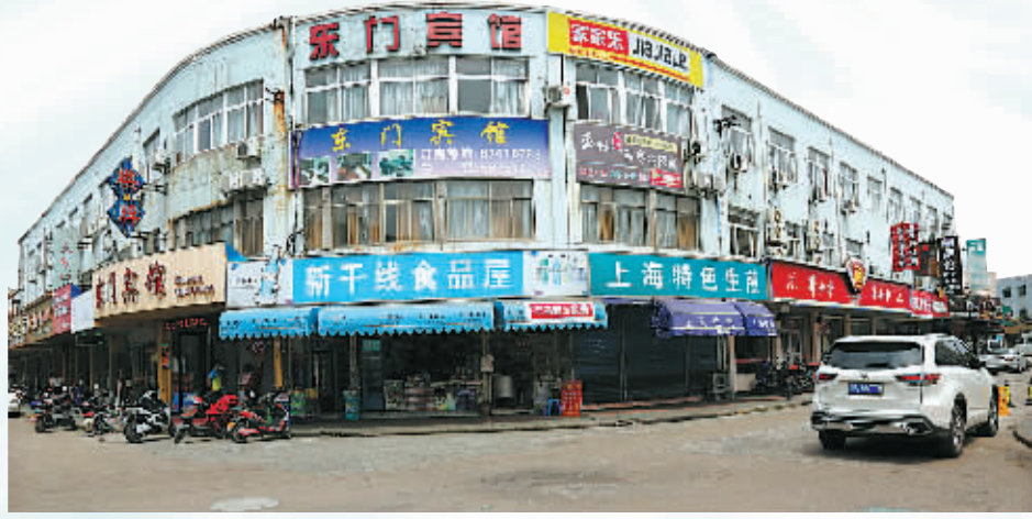
整治前的新干线食品屋。
