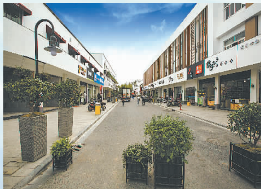
整治后的主街区沿街商铺。
