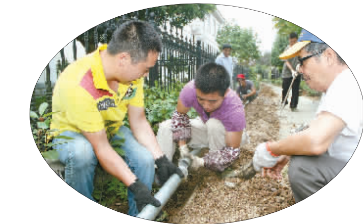
图为小区居民参与自来水管网改造。(陈斌国 余建文 摄)
