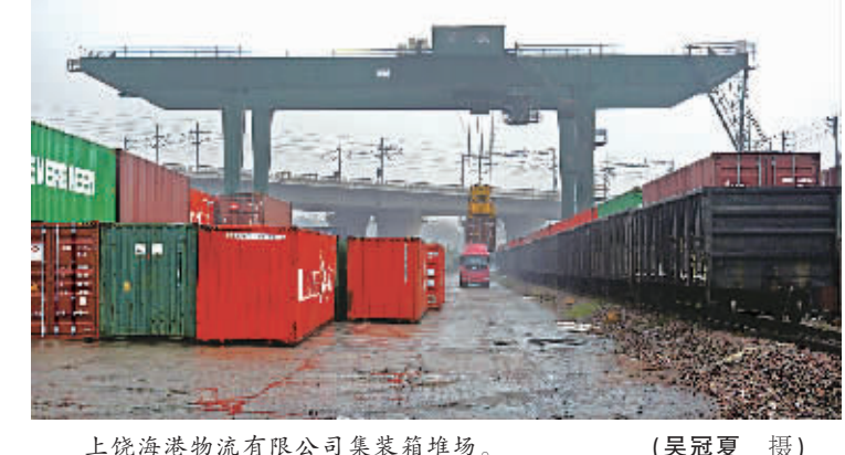
上饶海港物流有限公司集装箱堆场。(吴冠夏 摄)
