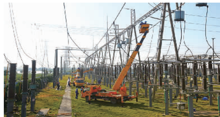
电力部门开展迎峰度冬集中检修。(苏许玮 仇九鼎 摄)
