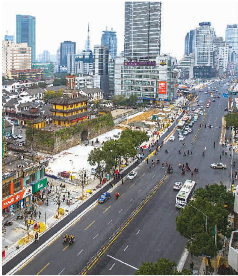
图为基本完成沥青摊铺的中山路新景观。(记者 刘波 摄)
