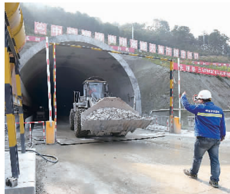
图为工人正在运输隧道内的渣土。(徐文杰 陈超 摄)
