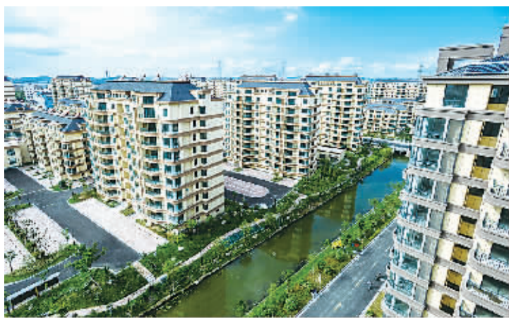
高桥镇高峰村新村建设小区及安置小区。
