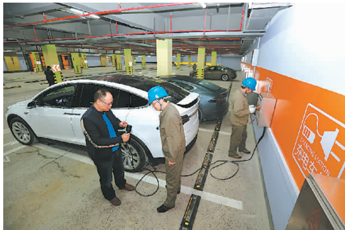
国网宁波供电公司工作人员为小区居民上门安装充电桩。
