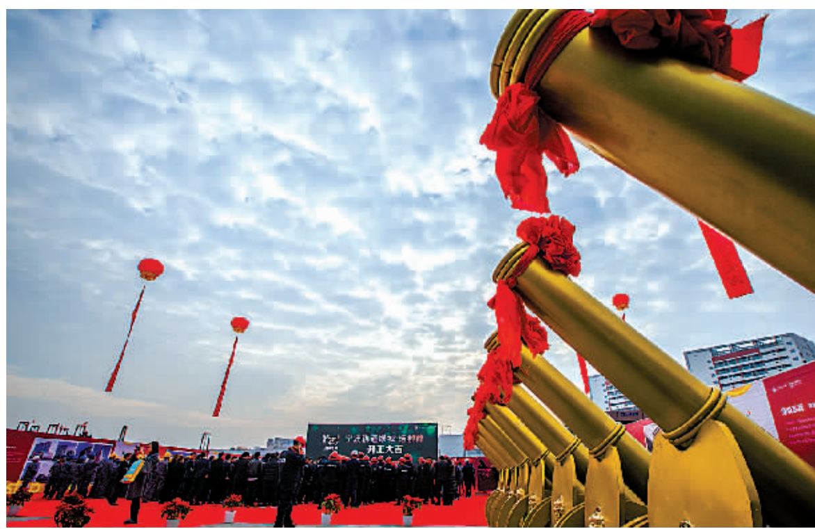
宁波轨道交通1号线邱隘东综合开发项目昨日开工。
