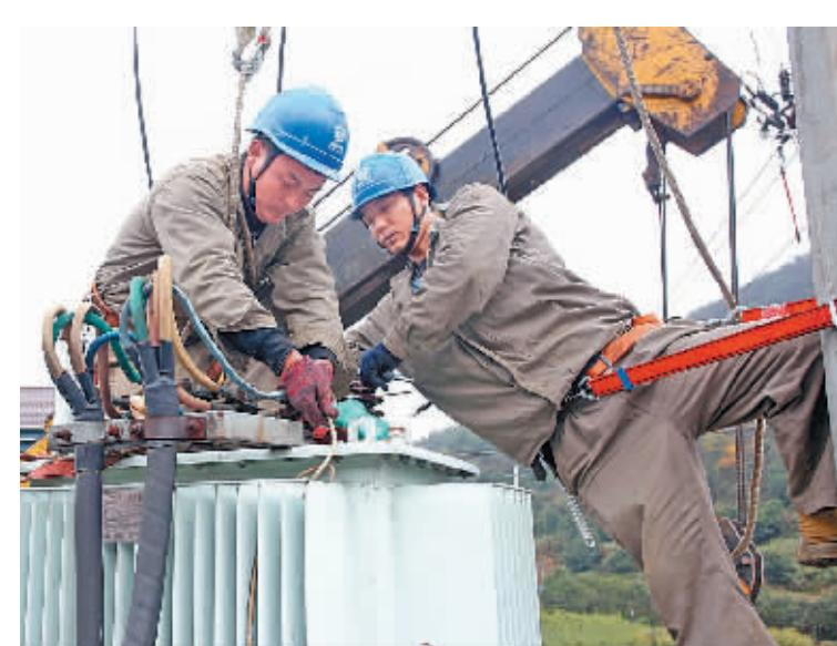
昨天, 鄞州供电公司安装分公司、大嵩供电所在塘溪镇东山村把400千伏安变压器增容到630千伏安。连日来, 鄞州供电公司组织力量抓紧电网改造与公用变压器新装和增容工作, 确保居民与企业在冬季正常用电。
