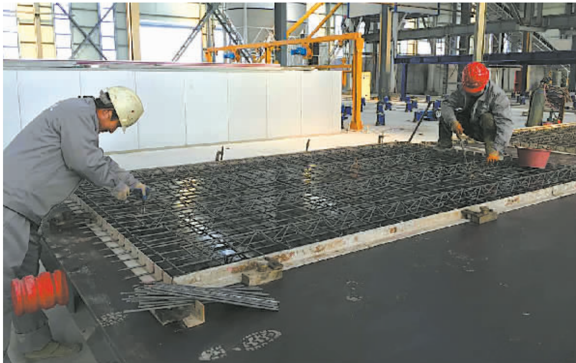
捷成建筑科技有限公司生产车间,工人正在根据模块设计生产楼板构件。(杨绪忠 摄)
