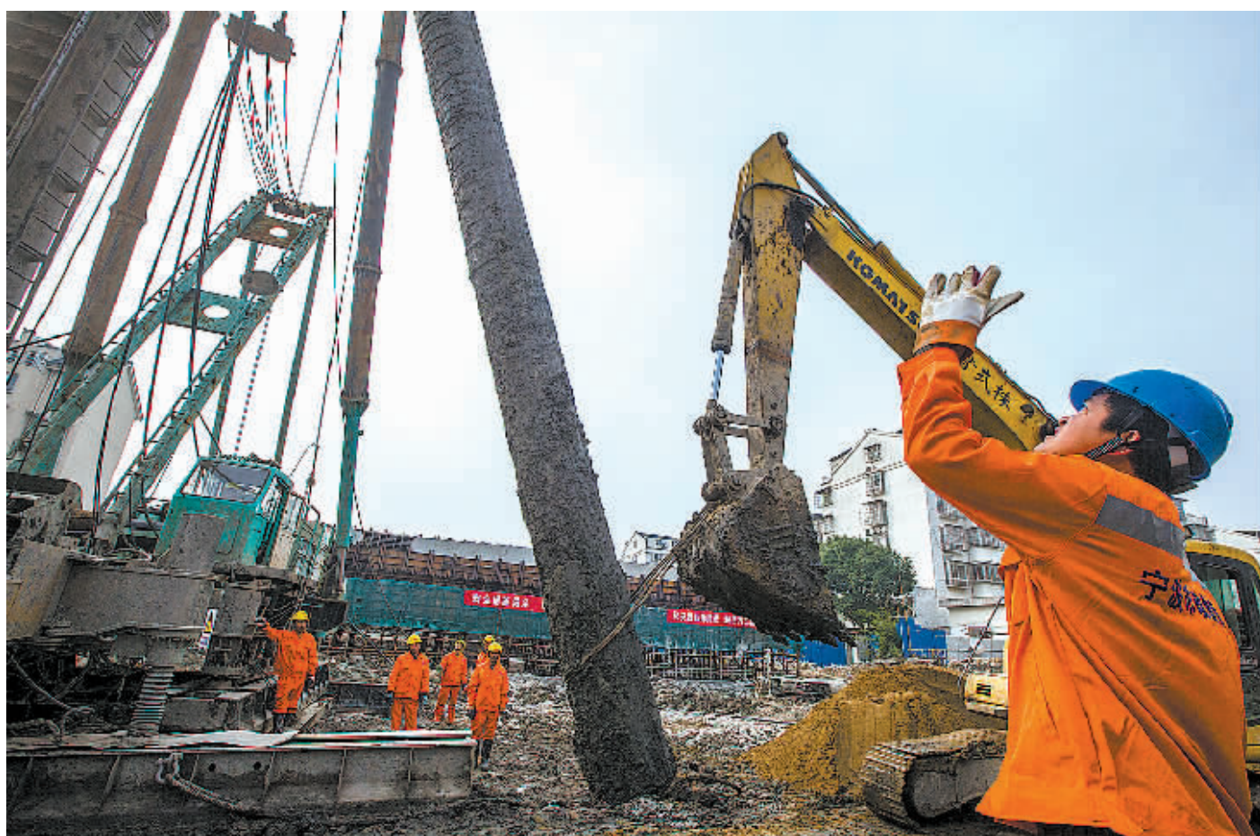
1月10日上午,金达路延伸段工程2#桥第18根桩基顺利拔除。为确保轨道交通5号线正常施工,金达路沿线需拔除28根直径60厘米的桩基,这些桩基是金达路延伸段工程开工前的老桥留下的。拔除工作自去年12月20日开工,剩余的桩基预计春节前拔除完毕。(刘波 陈晓艳 摄)
