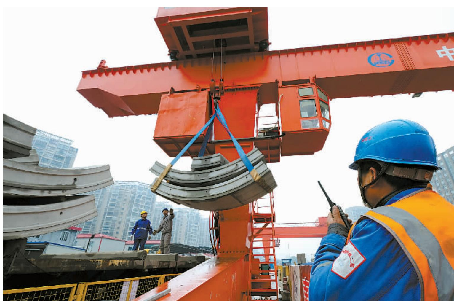
▲正月初八，宁波轨道交通三号线四明中路站施工现场，中铁二局的施工人员正在用龙门吊吊装盾构管片。
