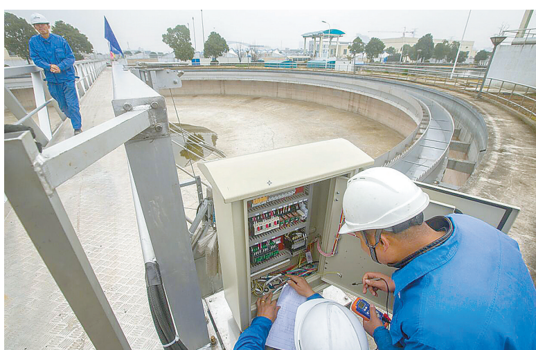
在南区污水处理厂二沉池上,工作人员正在调试刮泥机设备。(刘波 摄)
