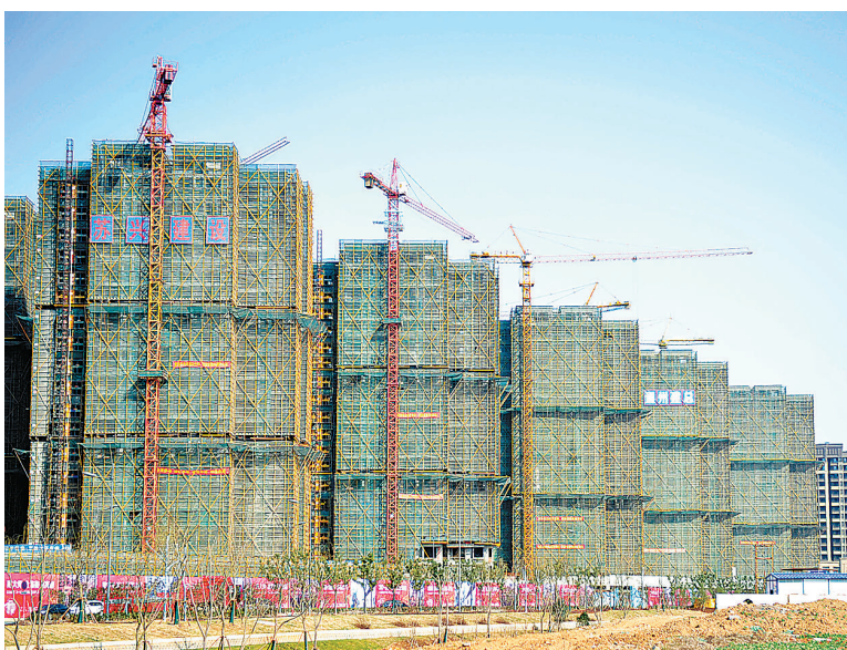
这是南京市江北新区一处正在建设的商品房小区。（新华社发）
