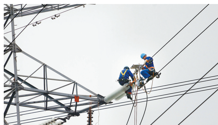
工作人员正在架空线上对测量设备进行调试。
