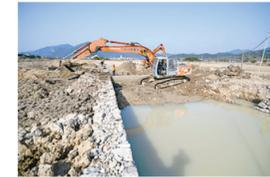
连日来,象山县茅洋乡长坑流域岸边,挖掘机机声隆隆,工人忙着砌石驳岸。长坑流域治理已完成70%的工程量,预计6月全面竣工。长坑流域全长2145米,流经乌石岐村和上缸村,已出现部分护岸崩塌、淤积较为严重等问题。该乡以“五水共治”为契机,计划新建长坑流域溪流护岸4290米,新建拦水坝11座,改建拦水坝1座,新建机耕路2145米,打造水清、岸绿、景美的生态景观,为乡村全域旅游发展添砖加瓦。
