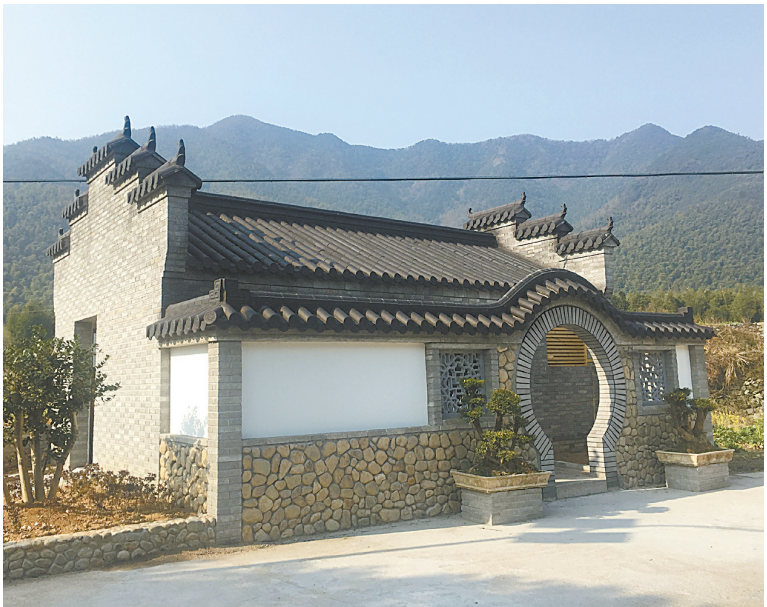
象山墙头镇方家岙村公共厕所。
