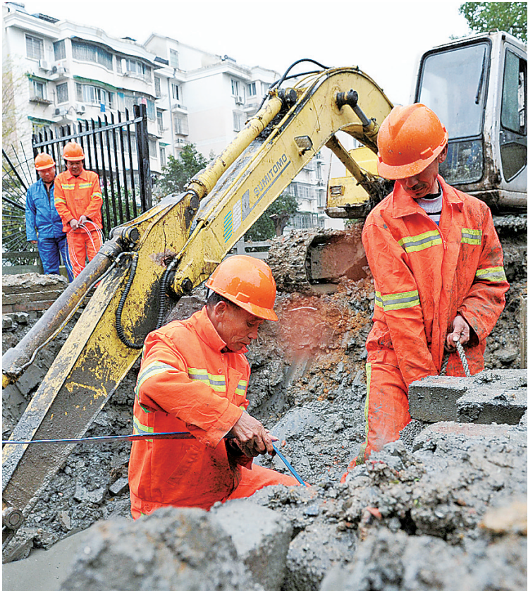
前天下午，鄞州区城管局排水养护人员在中河街道东裕社区内铺设新的污水管网。据了解，这是城管局启动的东裕社区截污纳管工程，也是该区“剿灭”劣Ⅴ类水的一项重要工作。（胡龙召 朱娇娇 摄）
