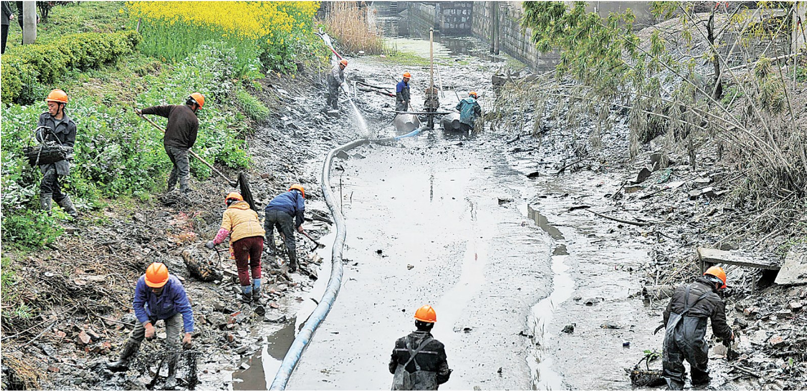
图为工作人员在杭州湾新区庵东镇马潭路村河道进行清淤工作。（郑添明 黄程 摄）
