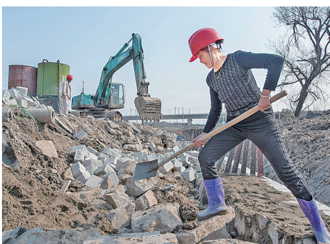
昨天下午,施工人员正在江北江心岛段进行河堤加固作业。(张昊桦 严龙 摄)
