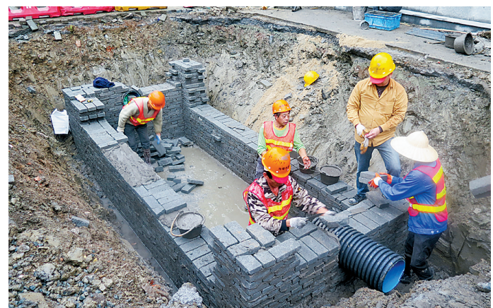
施工中的白云小区雨污分流工程。
