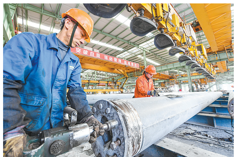
连日来,在位于鄞州经济开发区的浙东建材集团中淳高科技桩业股份有限公司,一根根数十米长的管桩源源不断走下生产线。近年来,该公司先后投入5亿元研发资金,由两名院士、140多名技术人员组成的科研团队,对用于高层建筑基础的静钻植桩等一批新产品进行持续的创新研发,帮助建筑单位实现了“无挤土、智能化、环保化”施工。(严龙 谭君飞 摄)
