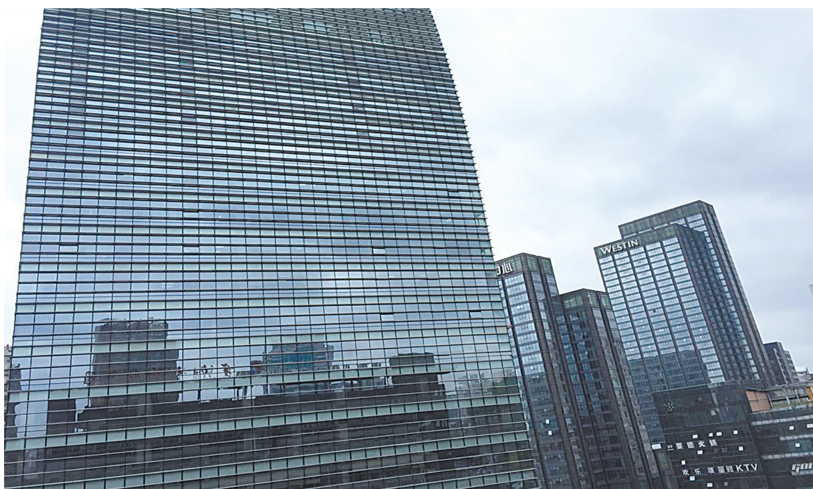
图为地处市中心的某大楼玻璃幕墙。
