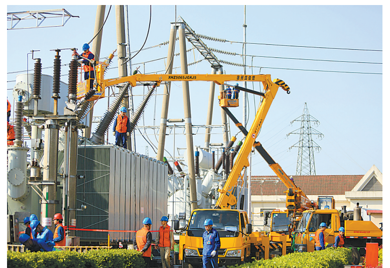
图为电力检修人员在蔡郎展开展检修工作。(仇九鼎 苏许玮 摄)
