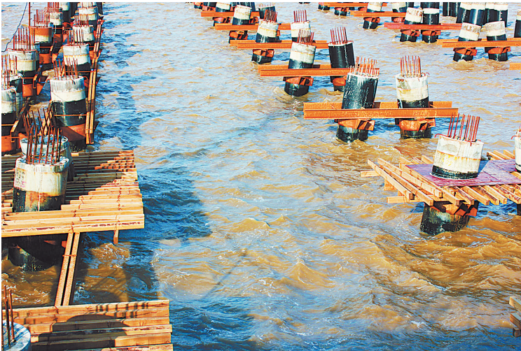
图为梅山港区6号码头施工现场。（张燕 吴彦坤 摄）
