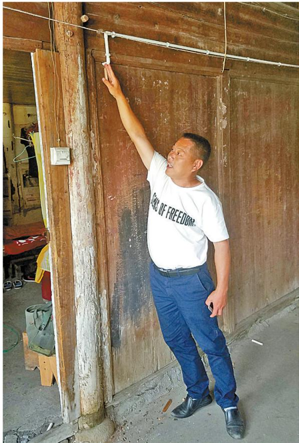
租房电线均套管重新接。(沈孙晖 摄)
