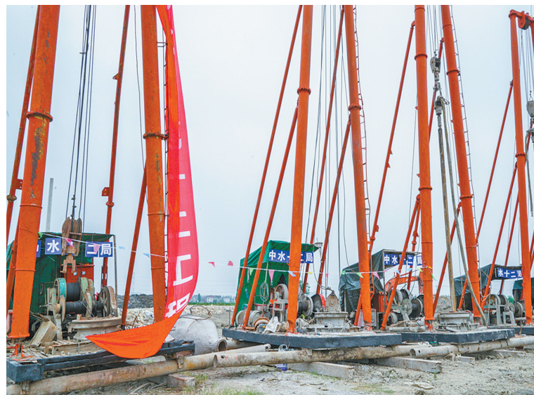
姚江二通道(慈江)工程开工现场
