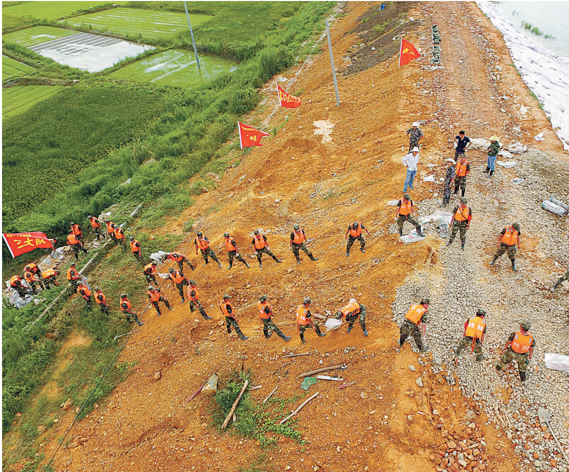
7月4日，武警水电二总队四支队官兵在防洪大堤上处置险情。受连续强降雨影响，鄱阳湖水位持续上涨，全面超警戒线。其中，江西省上饶市鄱阳县莲湖乡莲北圩堤坝多处出现管涌、渗漏等险情。武警水电二总队四支队驰援一线，投入抗洪抢险。
