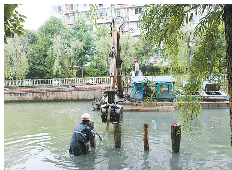
中塘河清淤工程中,为确保不挖到河坎,作业人员下河打桩。(王岚 顾梦婕 摄)
