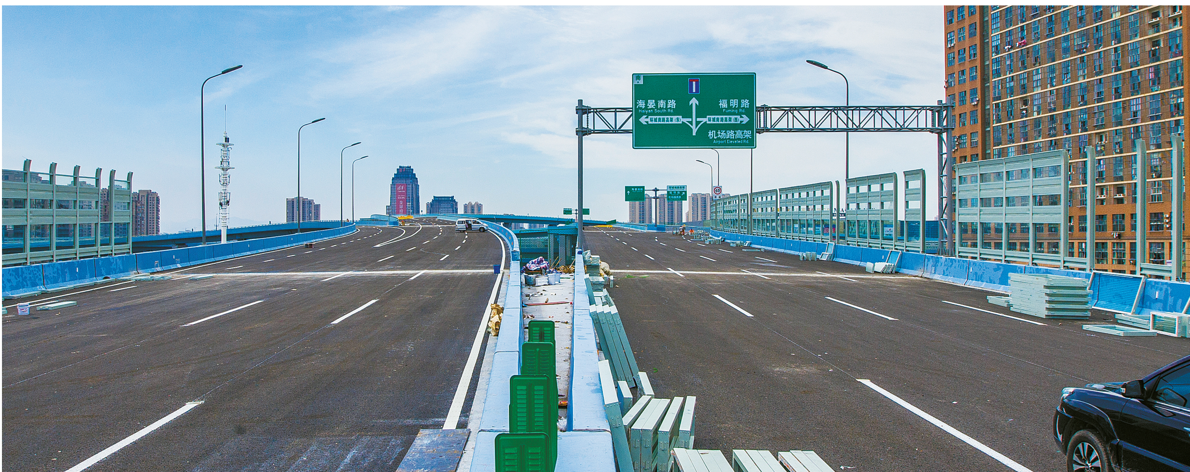
世纪大道快速路（东苑立交一百丈东路南）一期工程主线高架顺利建成。
