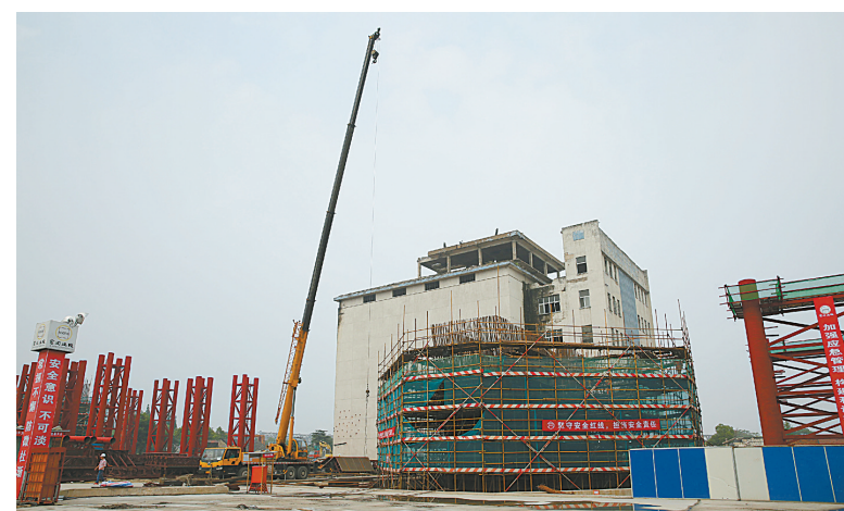
进入最后施工阶段的中兴大桥北岸主墩。(王涛 徐欣 摄)
