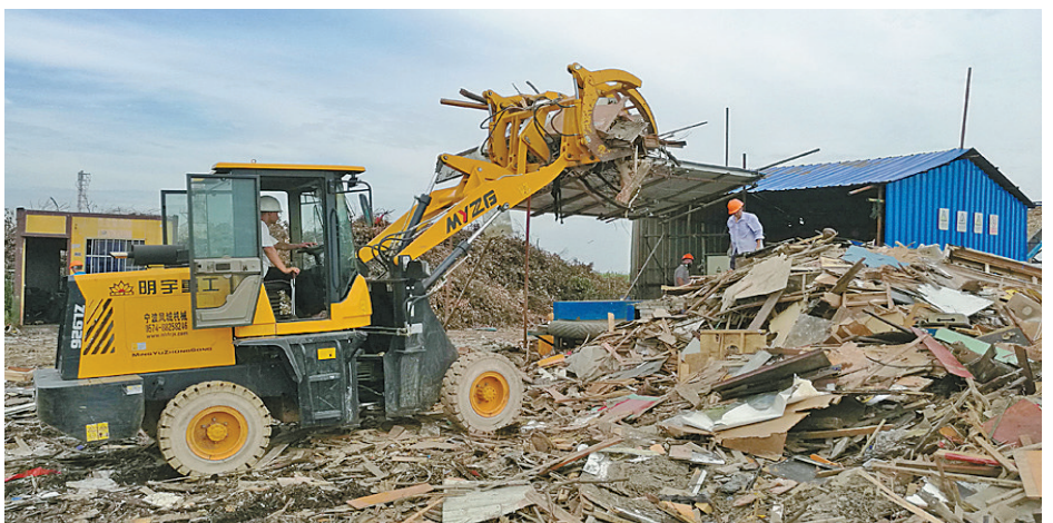
图为铲车将废木料送进机器粉碎。（余建文 摄）
