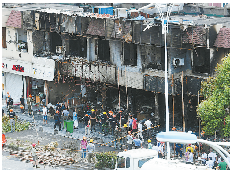
7月21日，建筑工人在事故现场搭脚手架。
