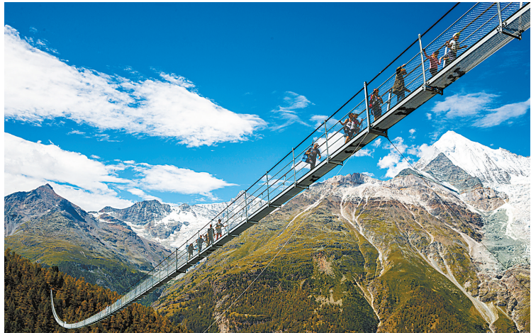
7月29日，在瑞士兰达，人们行走在“欧洲之桥”上。当日，世界最长的人行吊桥“欧洲之桥”正式竣工。这座吊桥全长494米，位于连接瑞士采尔马特和格拉申两个村庄的“欧洲小路”上方。(新华社/欧新)
