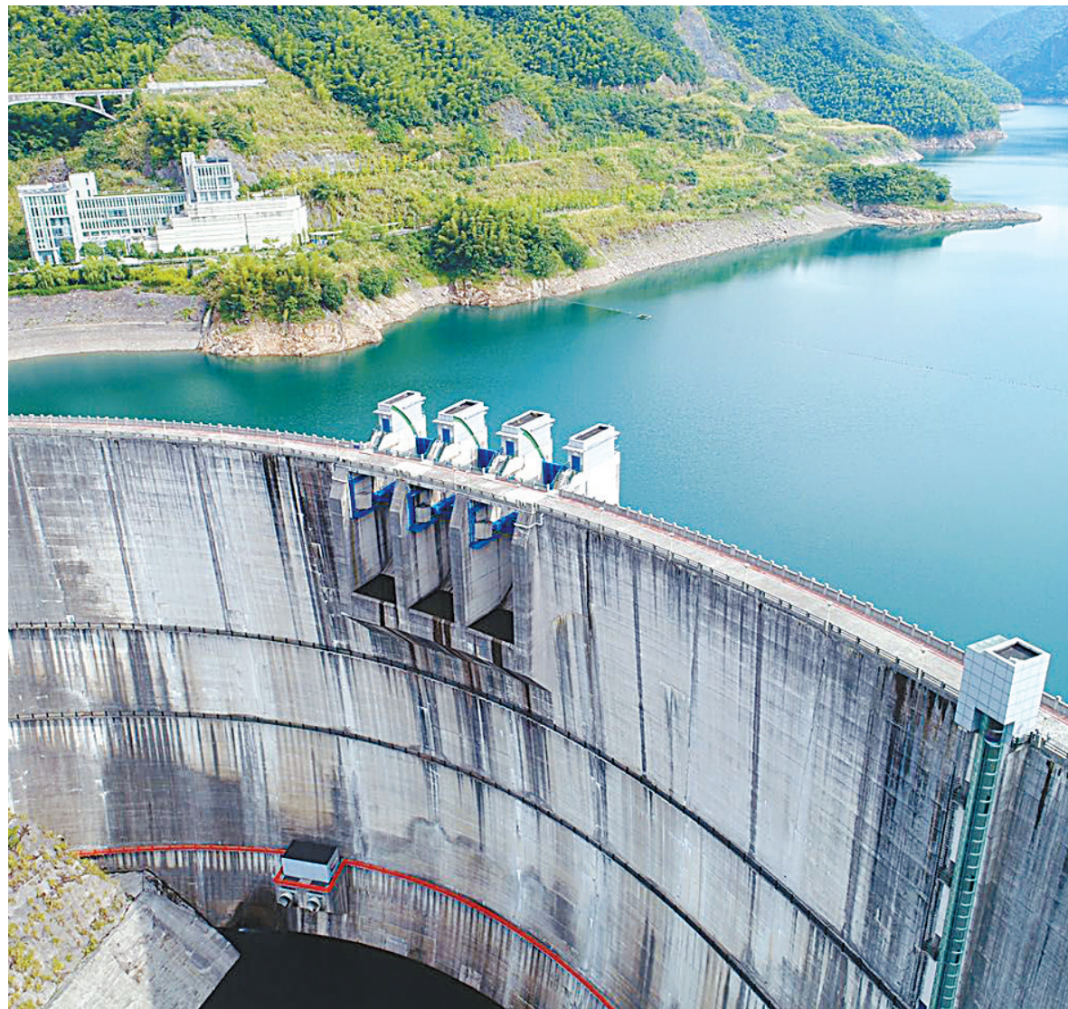
图为周公宅水库大坝。
