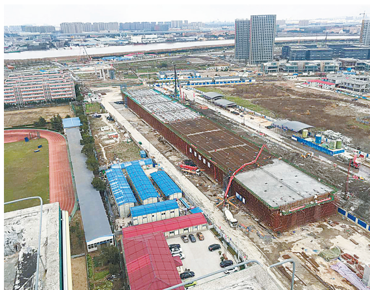
三官堂大桥连接线工程施工中。（本版图片由市直机关工委提供）
