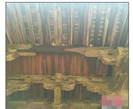
据8月30日《北京青年报》报道:古建筑爱好者唐大华,在参观号称“古建筑第一瑰宝”的山西佛光寺东大殿时发现,殿内有10余处漏雨点,担心会对这一唐代木结构古建筑造成损害。寺庙维护方山西古建筑保护研究所回应,已经了解到相关情况,维修方案2015年就已经上报,目前正处于专家评审阶段。
