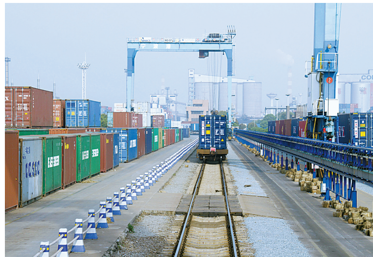
图为铁路北仑港站作业场景。
