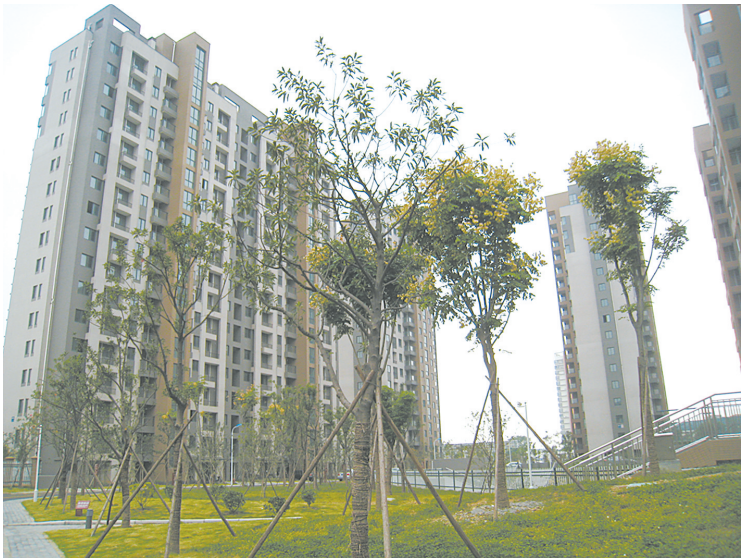
民生工程安置房
