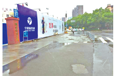
路面已恢复平整，非机动车、行人能正常安全通行。(仇龙杰 摄)
