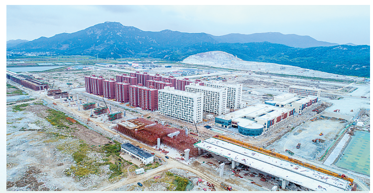
正在建设中的航天科技城 (周科 摄)
