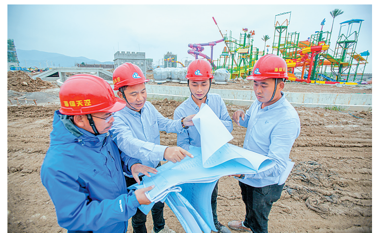
海阔天空水上乐园施工现场 (周科 摄)
