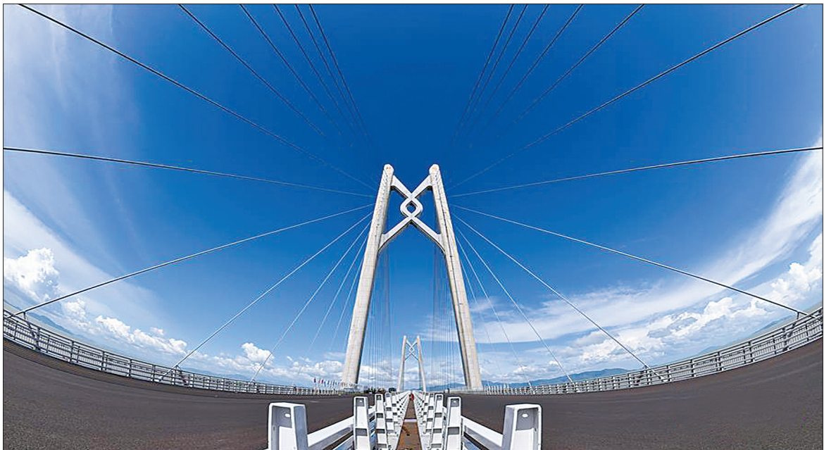
港珠澳大桥上的“中国结”造型桥塔。（新华社发）
