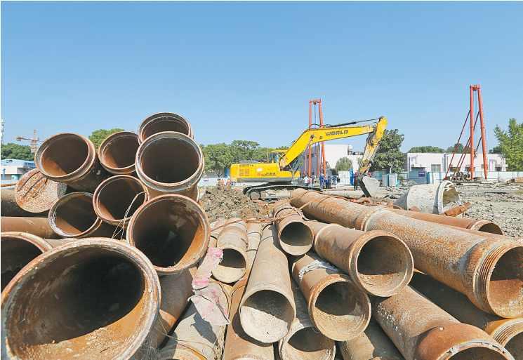
图为施工现场。
