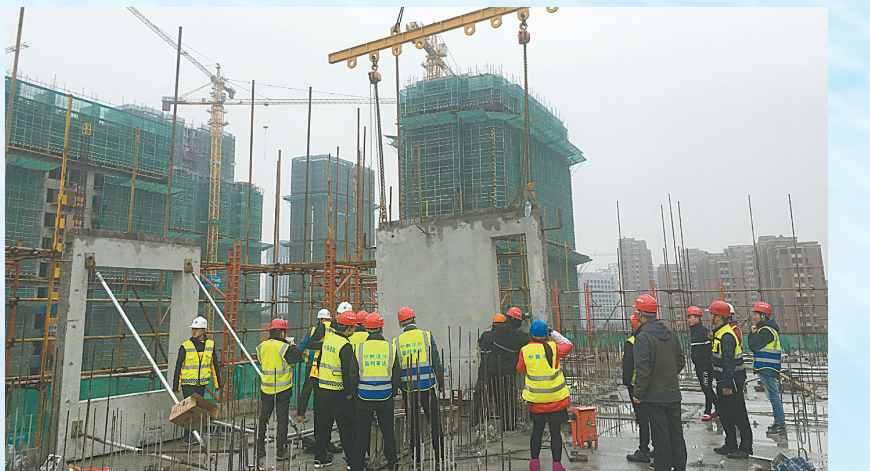
建筑工地上正在吊装的预制墙板
