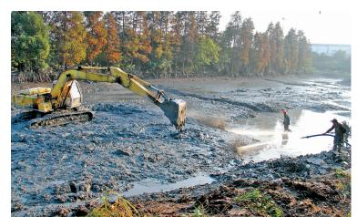
昨天, 在北仑区沿山大河 (保税区段) 清淤疏浚工程现场, 施工人 员在清理河底淤泥。当前正值冬修水利的黄金时期,北仑区水利部门在 汛期过后加快推进行洪河道清淤疏浚工程,改善河道水质,达到"水 清,河畅,岸绿,景美"的目标。 (索向鲁 厉晓杭 摄)
