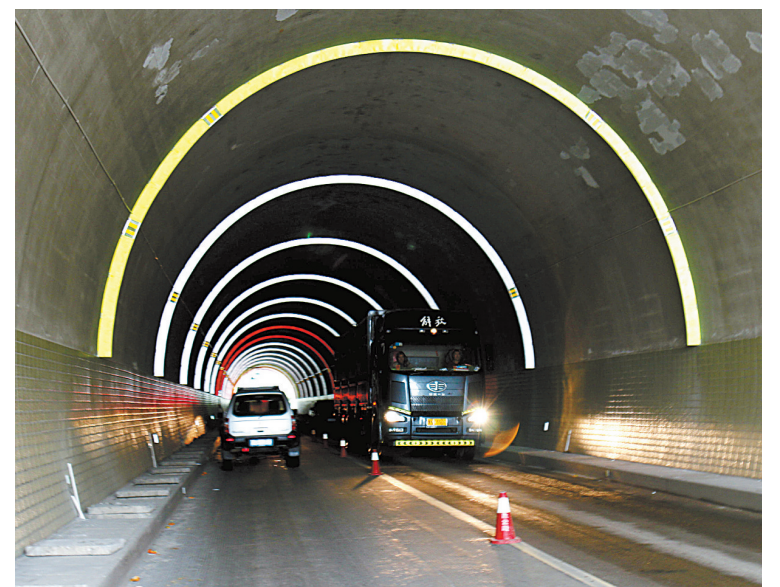
图为前段时间仍在建设中的“彩虹隧道”。(郑芝 沈孙晖 摄)
