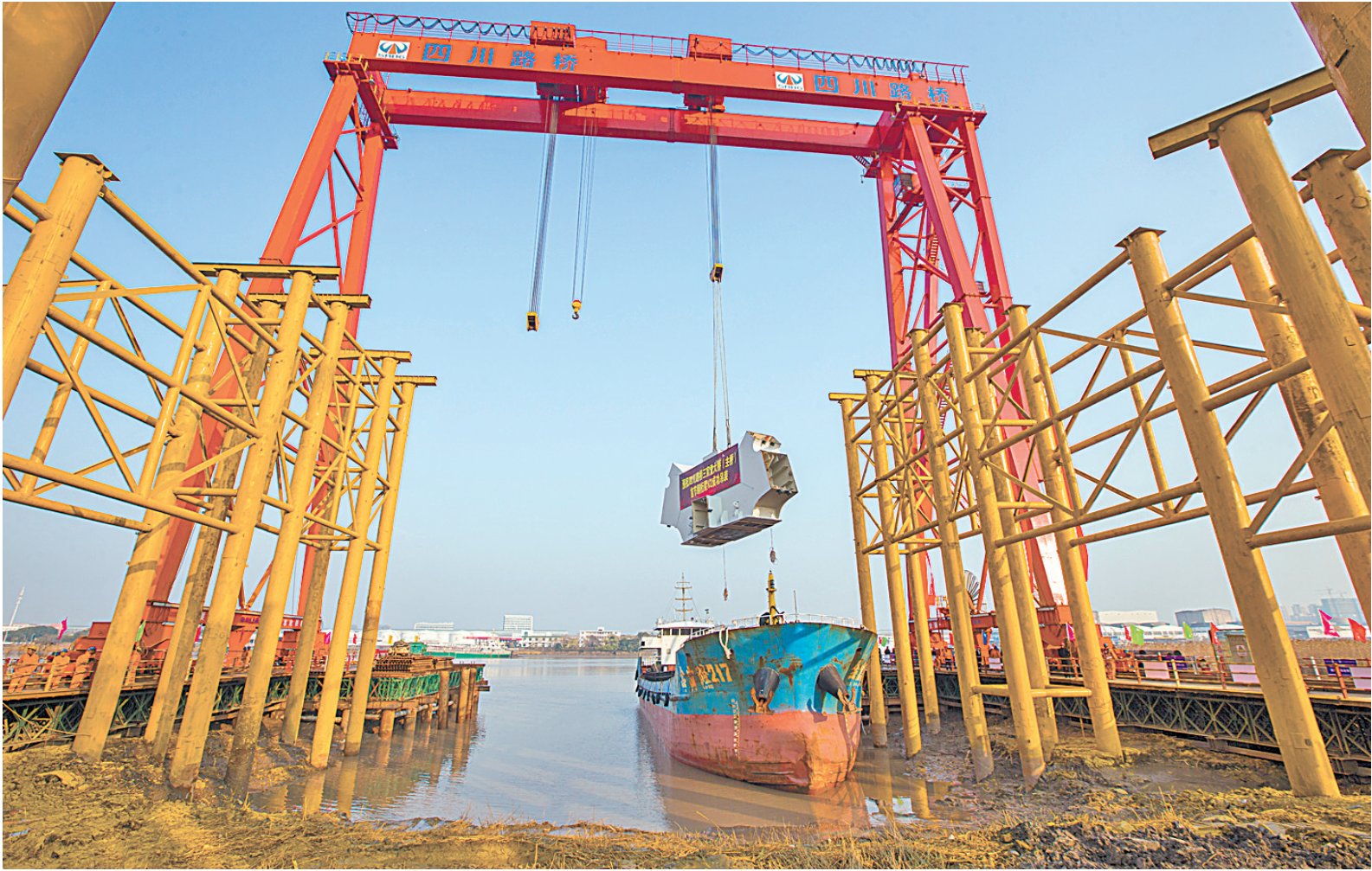
三官堂大桥及接线工程主桥的首段钢桁梁安装现场。（刘波 摄）
