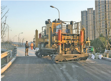
12月19日，匝道内几名工人正在施工。（仇龙杰 摄）
