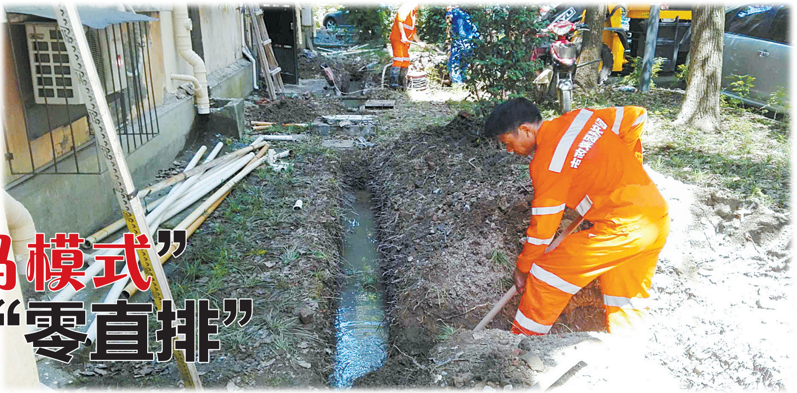
图为中马街道改造老旧小区市政雨污管网。(徐欣 林嗣健 摄)
